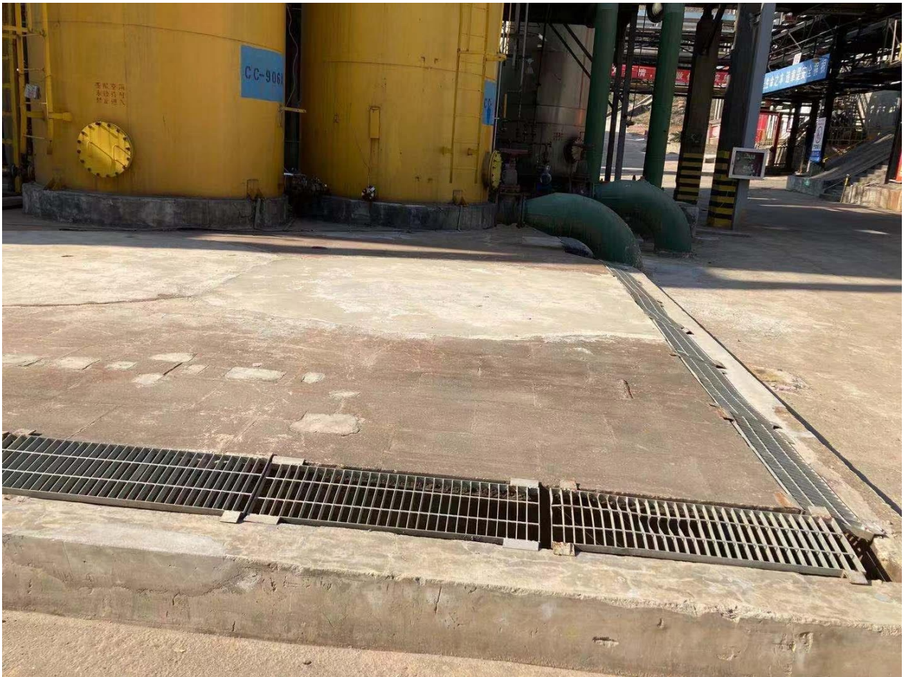
图 4.2-2 罐场泄露收集沟
