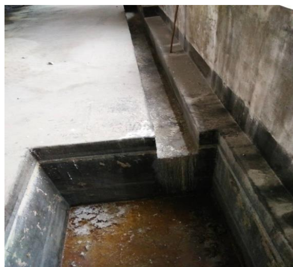
危废库导流槽，积液坑
