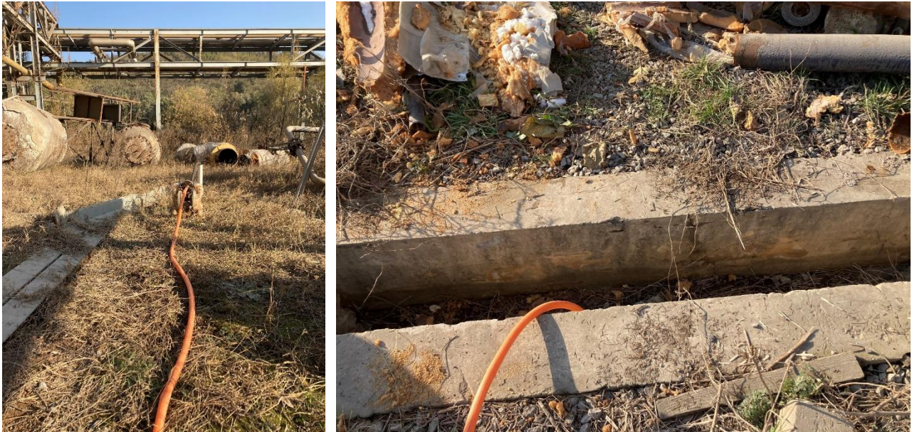
图 5.2-3 气膜泵抽取地下水
